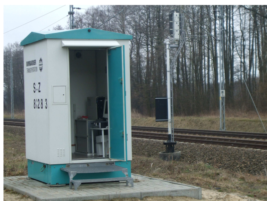
Fot. 4. Kontener sbl z widoczną jednostką centralną do zapisu nagrań z kamer
